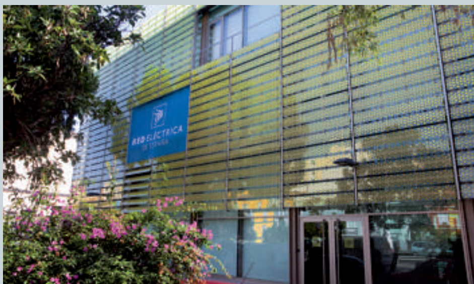
Sede de Red Eléctrica en Las Palmas de Gran Canaria
